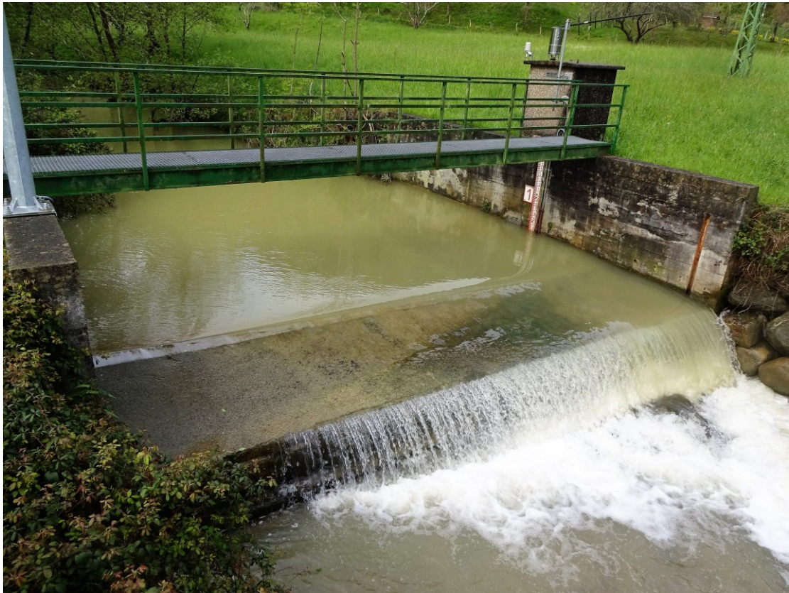
3.Argazkia Bizkaiko Foru Aldundiaren AR01 ur emaria neurtzeko estazioa, Artibai ibaian (Argazkia: ANBIOTEK).
